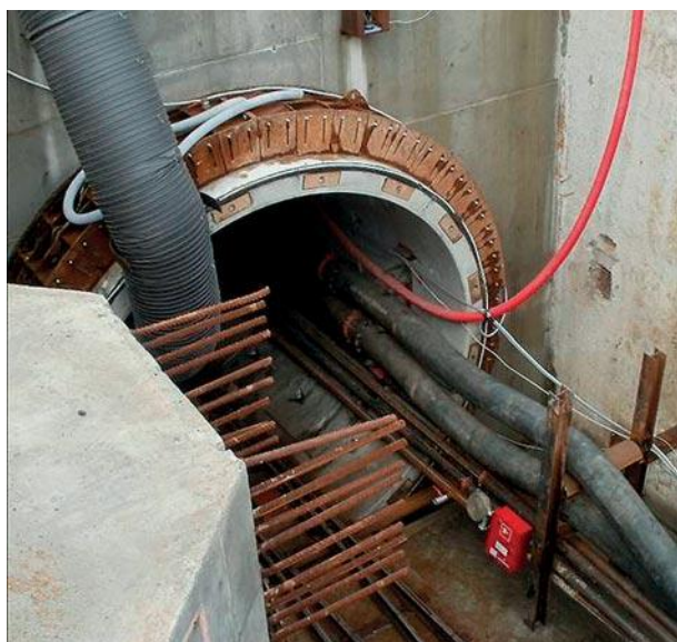
Ejemplo de un proyecto de construcción de túneles utilizando los Decanters Flottweg
